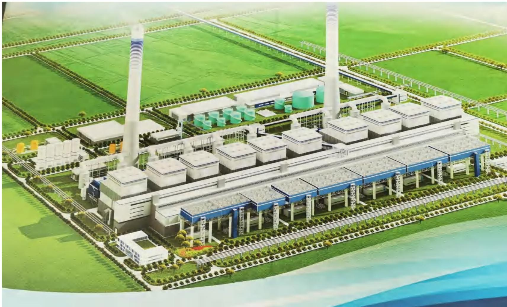
号称世界最复杂的动力大系统（10台锅炉，6个除氧器，8个发电机组，10套环保岛，2个具有8个压力等级的复杂管网）
